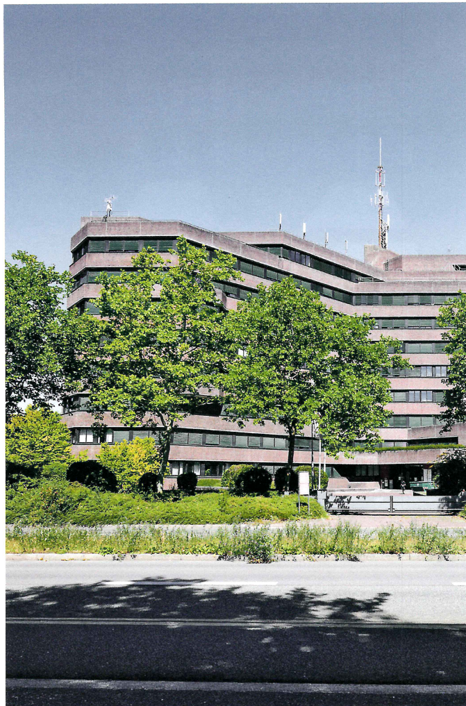
Das Anfang der 1970er-Jahre für die Oberpostdirektion errichtete und später von der Telekom genutzte Gebäude ist verkauft worden und soll renoviert werden.
