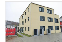
Wärmepumpen, Solarplatten und Wärmedämmung reduzieren in Waldshut-Tiengen den Energieverbrauch auf 15,8 kWh/m 2 /Jahr (Bundesdurchschnitt ca. 160)
